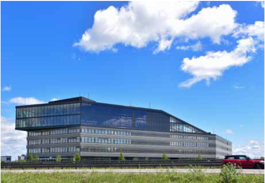
// Weitblick 1.7 Augsburg, moderner Bürokomplex mit 17.300 m² vermietbarer Gesamtfläche.
