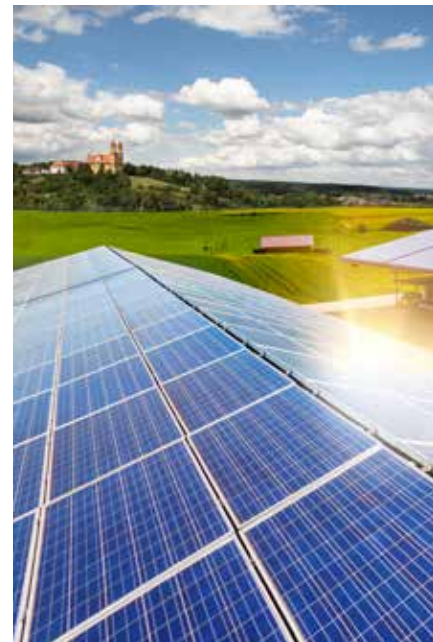
// Bereits rund zwei Drittel des von der ODR eingespeisten Stroms stammt aus regenerativen Quellen.
